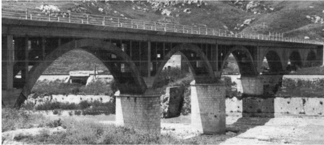
Ristrutturazione di un ponte ad archi sul fiume Platani (AG) -1980
